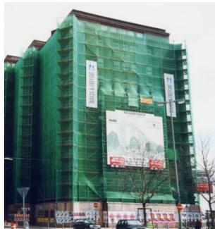
Gerüstschutznetze sind in unterschiedlichen Qualitäten und Ausführungen für alle gängigen Gerüst-Standardbreiten erhältlich. Dadurch sind sie schnell und mit geringem Aufwand zu montieren und zu demontieren.
