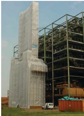
Gerüstschutzplanen sind in unterschiedlichen Qualitäten und Ausführungen für alle gängigen Gerüst-Standardbreiten erhältlich. Dadurch sind sie schnell und mit geringem Aufwand zu montieren. Aber auch bei Sonderkonstruktionen findet sich ein breites Einsatzgebiet.
